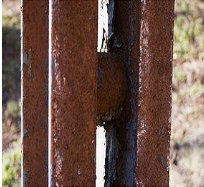
ნახ.18. რკინის დაჟანგული დეტალები
