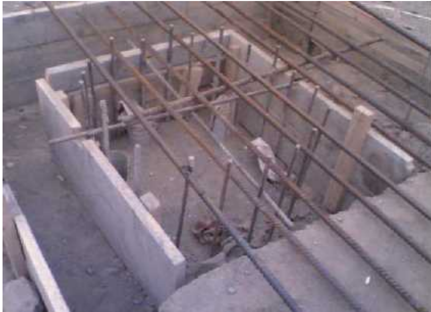
სურ. 9.26. როსტვერკის ყალიბის მოწყობის პროცესი დაბეტონებამდე.
