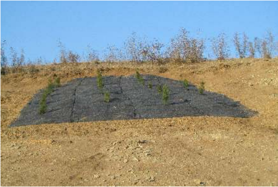
სურ. 12. ფერდობზე დამონტაჟებული გეოსალიჩა “Coton Mat” (ხედი ქვევიდან ზევით)
