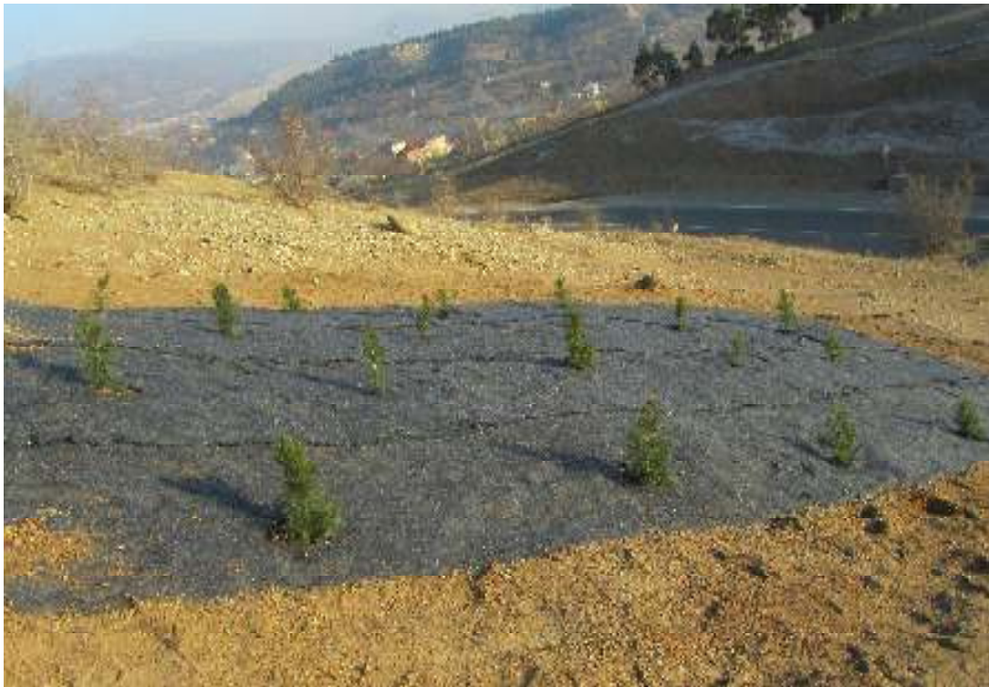
სურ. 13. ფერდობზე დამონტაჟებული გეოსალიჩა “Coton Mat” (გვერდხედი)
