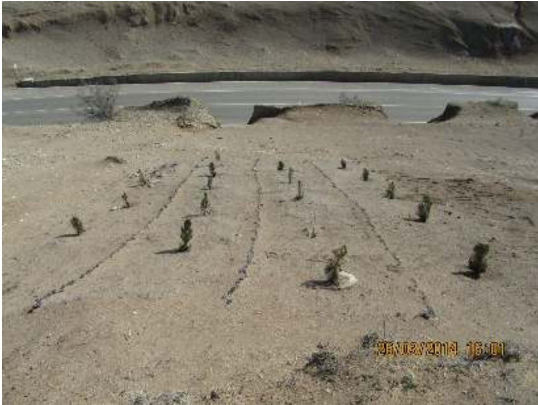
სურ. 14. ფერდობზე დამონტაჟებული გეოხალიჩა “Coton Mat”-ი და დარგული ხე მცენარეები. (3 თვის შემდეგ).
