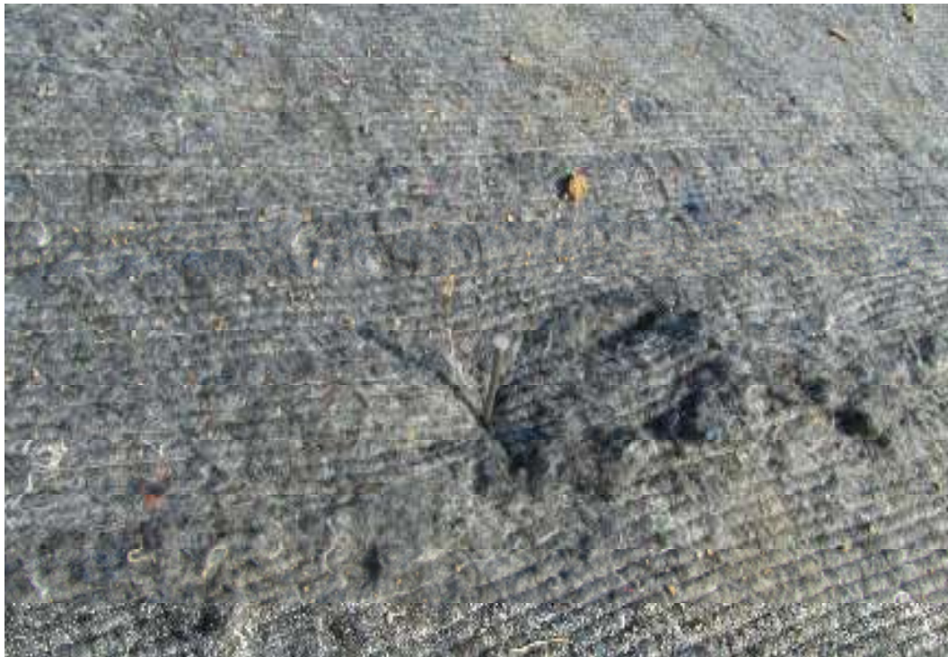
სურ. 9. ანკერების საშუალებით ფერდობზე გეოხაღისა “Coton Mat”-ის მონტაჟის პროცესი
