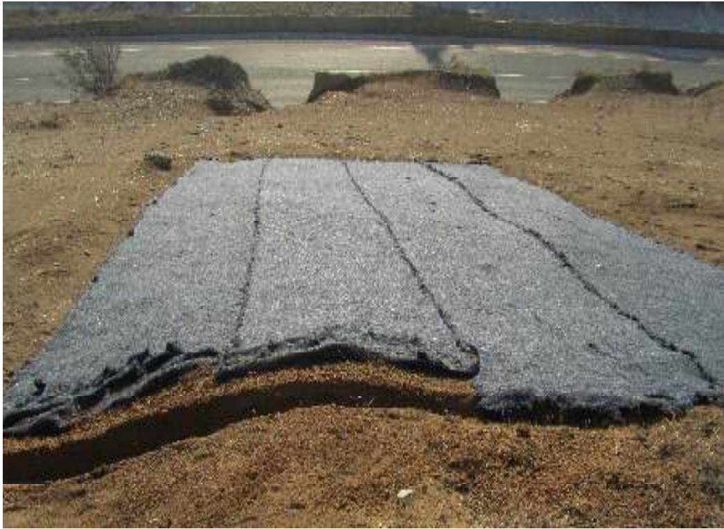
სურ. 8. ფერდობის დასაწყისში გაყვანილ თხრილში გეოხაღისა “Coton Mat”-ის ჩაფენის პროცესი
