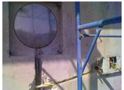
ნახ. I.34. ბეტონის დაძაბულობის მრიცხველი, დამონტაჟებულია ლითონის სამონტაჟო ნიშაში ცემენტის ხსნარის ჩასხმამდე
