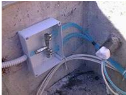
ნახ. I.30. DSM სისტემის ჰიდრაულიკური შეერთების კვანძი გრუნტის ჯდენის კონტროლისათვის
