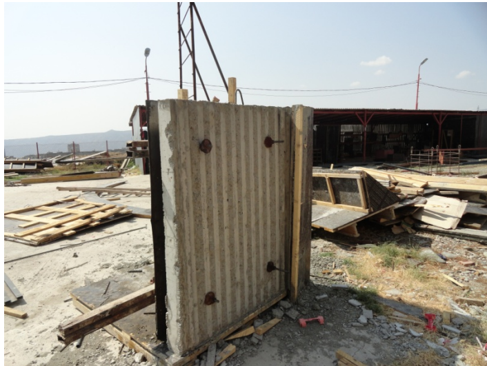
ფოტო 13: დაბეტონებული I (გარე) შრე ტალღოვანი ვერტიკალური ღარობებით. მონტაჟდება II საყალიბე ფარი II შრის დასაბეტონებლად;
