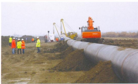
არსებული კოროზირებული სექცია შეიცვალა ახალი 1200მ-იანი მილსადენით.
